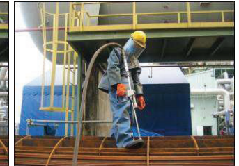
ขณะสายหลุดจากบ่าทำให้สาย และปืนสับคไปโดนโดนเท้าด้านขวา
